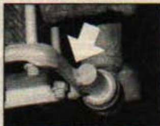
Primitive Detaillösung: Stoßdämpfer-Befestigung nachträglich angeschweißt
